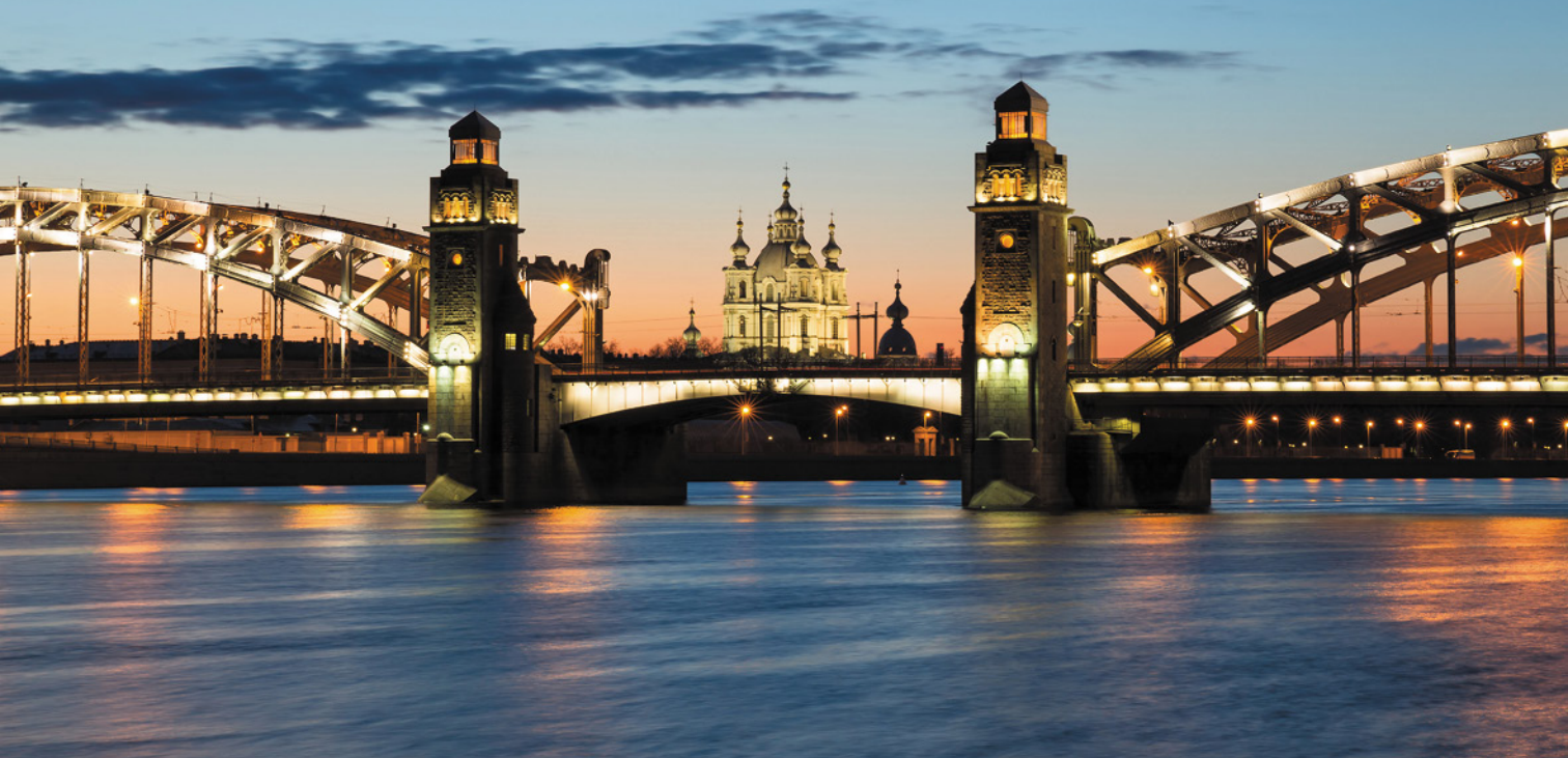
Большеохтинский мост в Санкт-Петербурге Bolsheokhtinskiy bridge in Saint Petersburg
